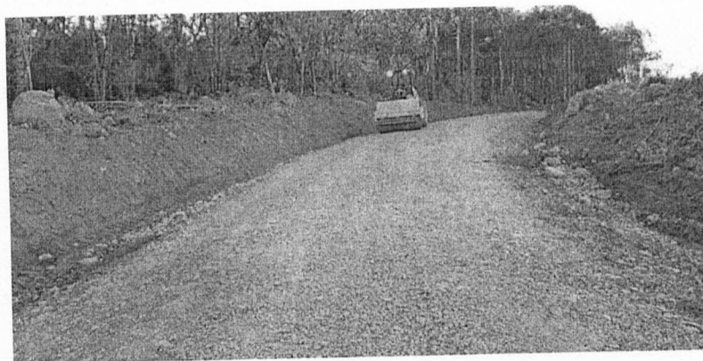
Readequação de estradas
